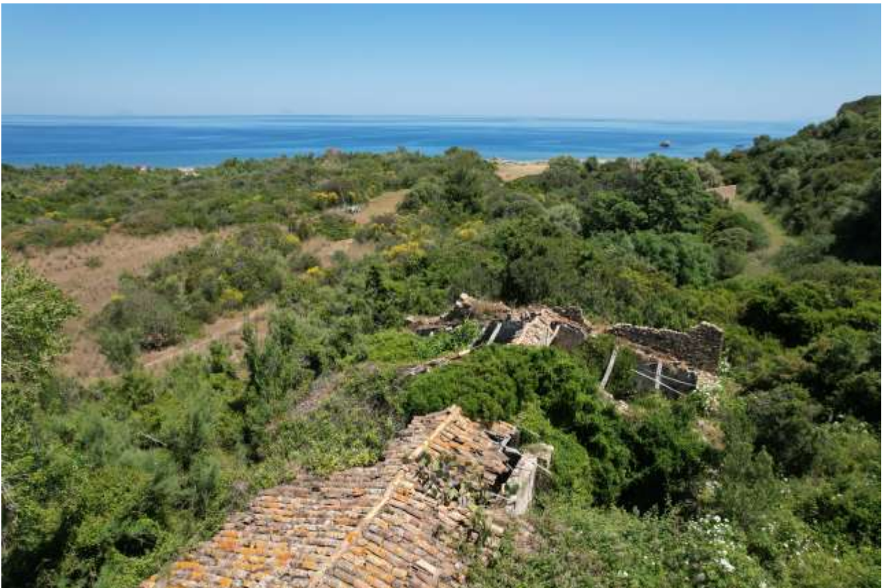
Vista da Sud della copertura
