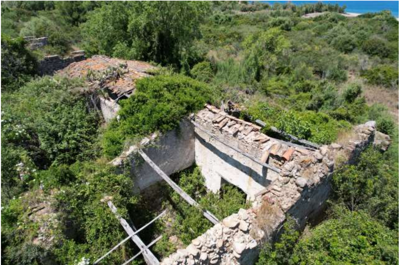
Vista da Est della copertura
