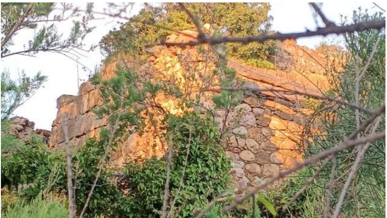
Vista da Sud-Ovest della gora, torre dell'acqua e locale macine
