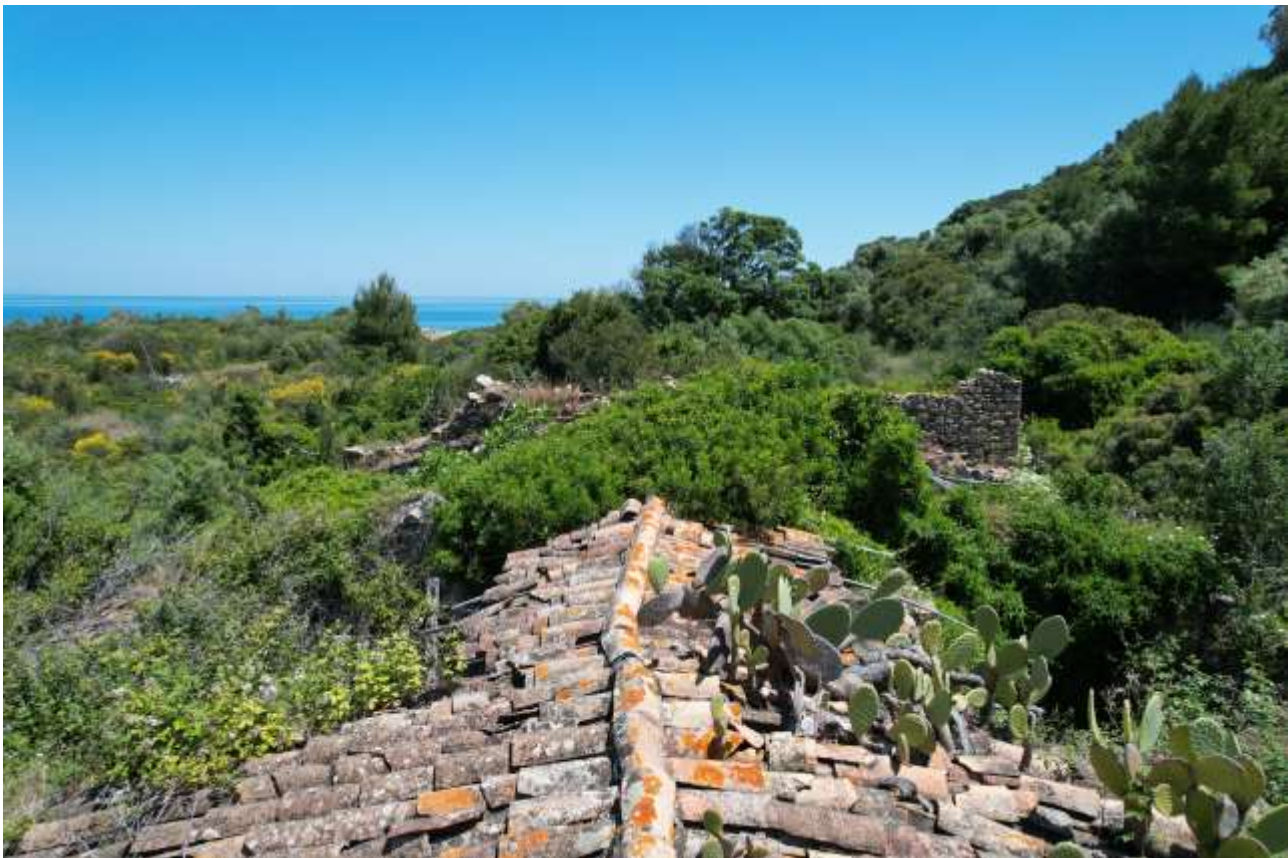
Vista da Sud della copertura
