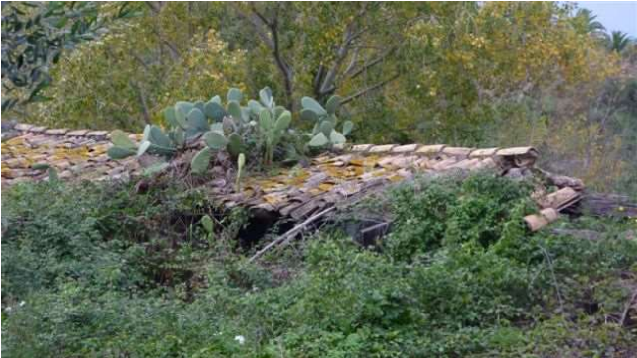
Vista da Sud-Est della copertura
