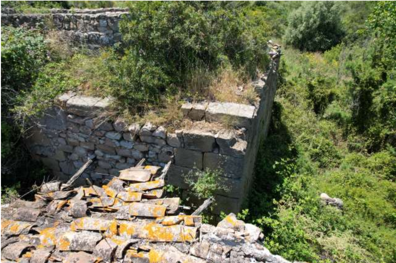
Vista da Nord-Est della gora, torre dell'acqua e locale macine
