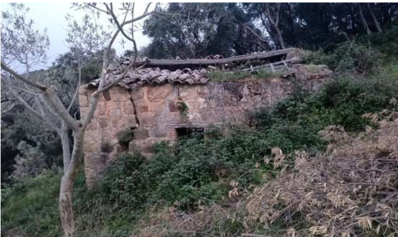
Vista fabbricato da Nord-Ovest
