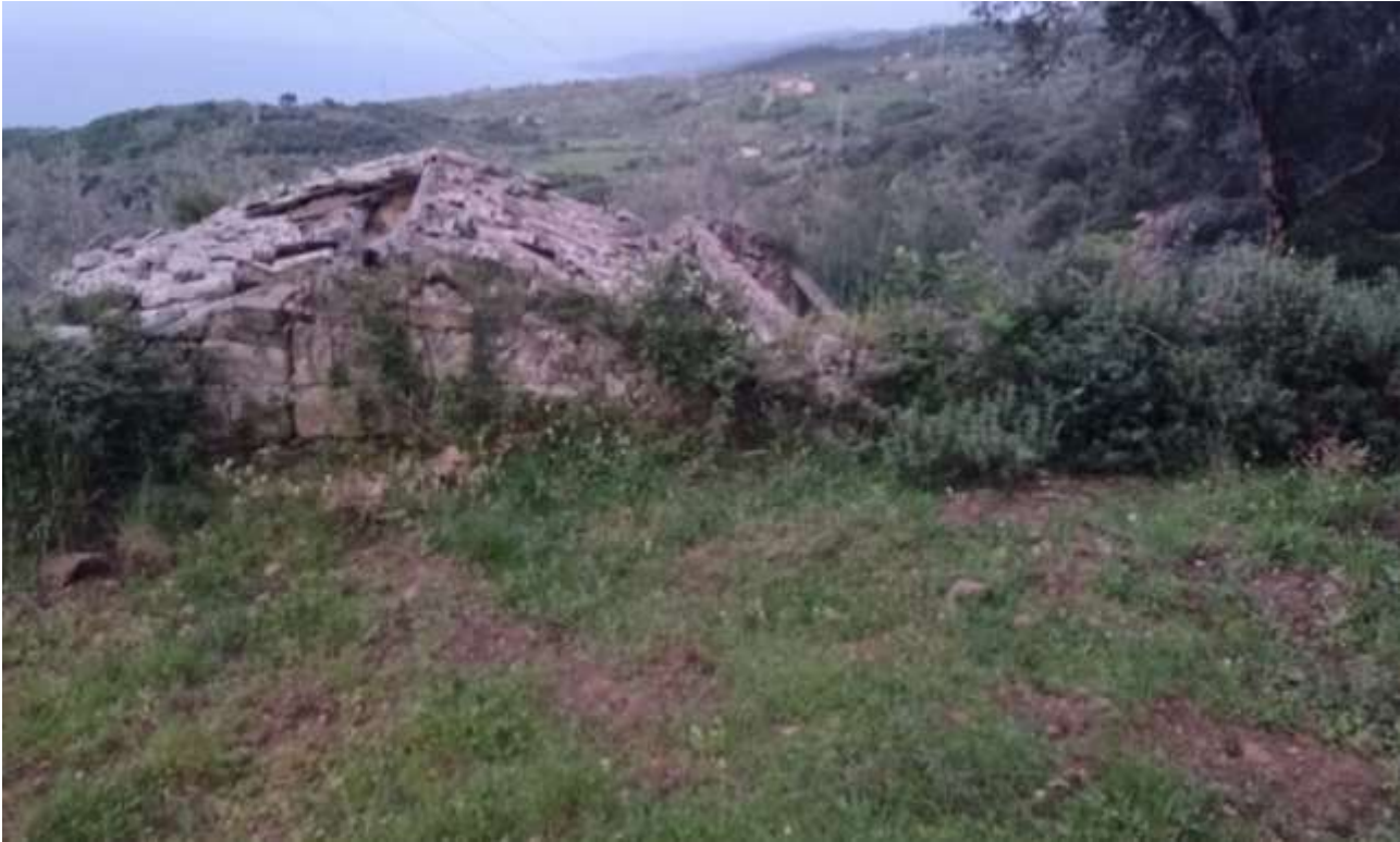
Vista fabbricato da Sud-Ovest
