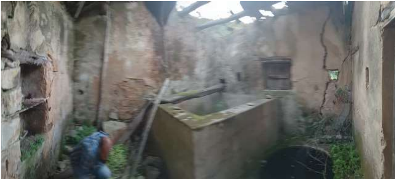
Vista interno palmento
