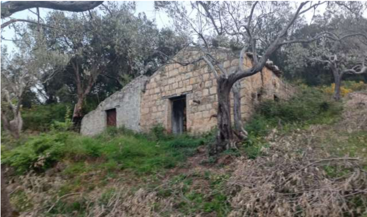
Vista fabbricato da Nord-Est
