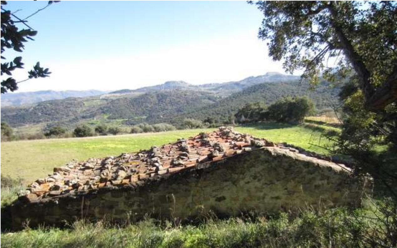
Fabbricato da da Nord – Ovest
