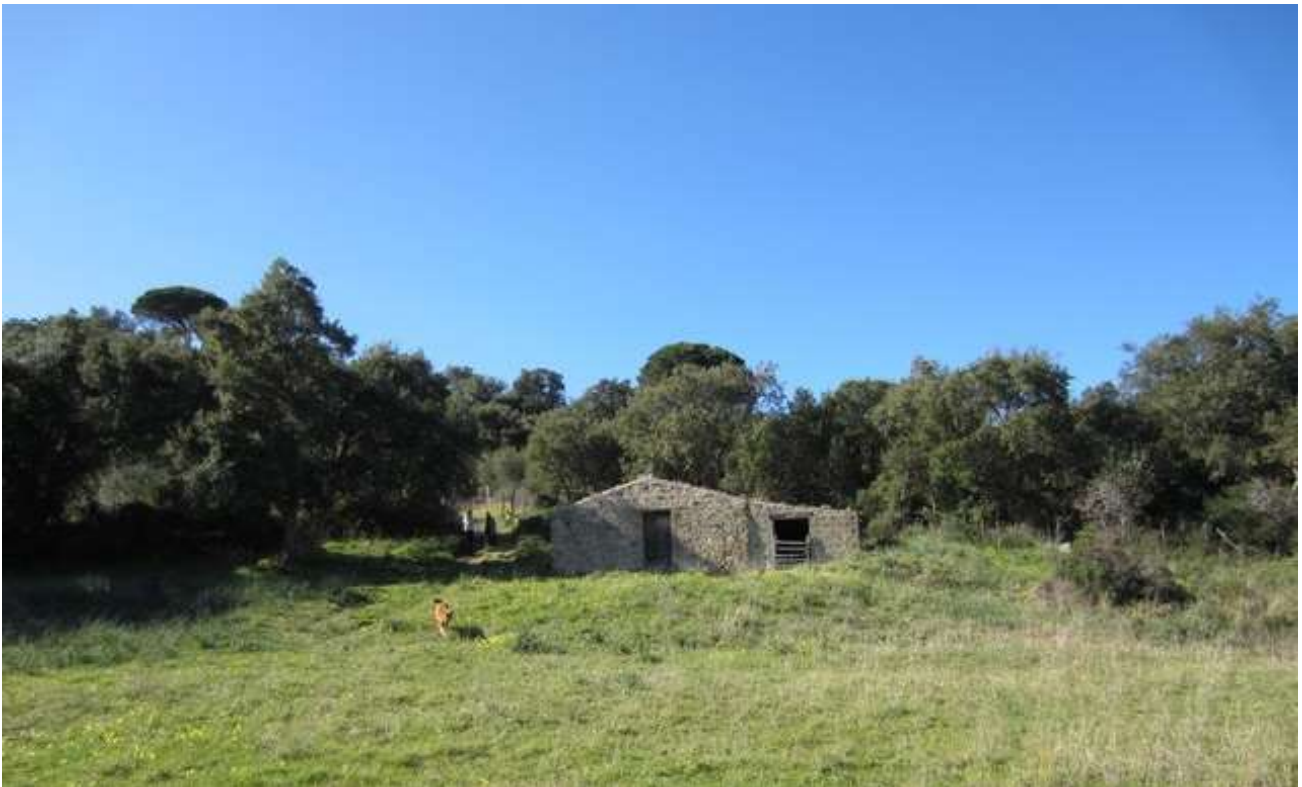
Fabbricato da Sud - Est
