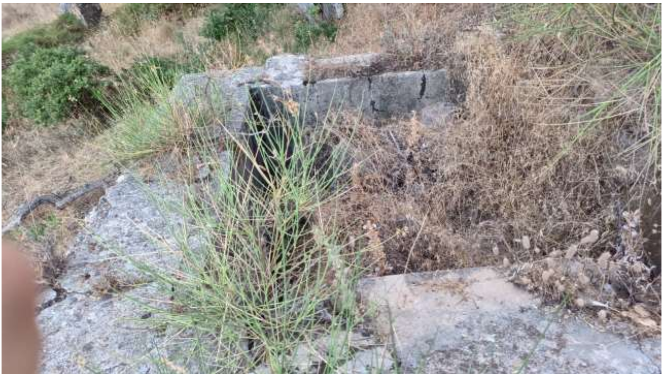
Vasca di raccolta - interno
