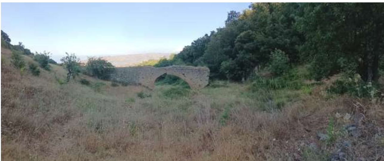
Vista da Sud-Ovest lato monte
