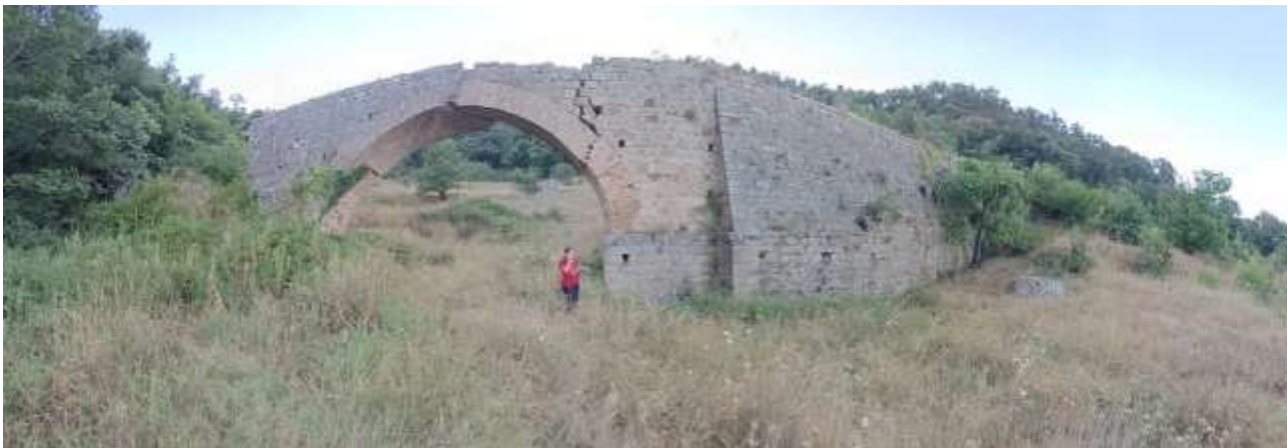
Vista da Est lato valle
