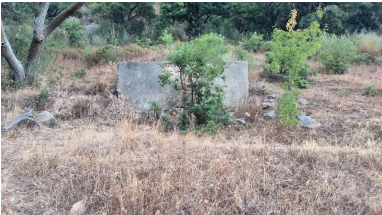
Vista da Ovest della vasca di raccolta
